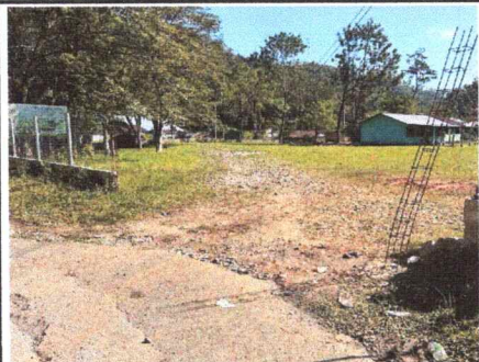
MUESTRA LA ENTRADA PRINCIPAL AL CENTRO EDUCATIVO SIN PORTON.
